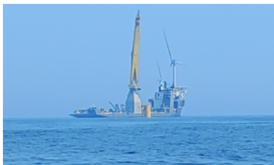
FIGURA 14. Buque grúa y equipamiento de instalación utilizados en la fase de construcción de parques eólicos marinos. Fuente: Josep Lloret (ICM-CSIC).
