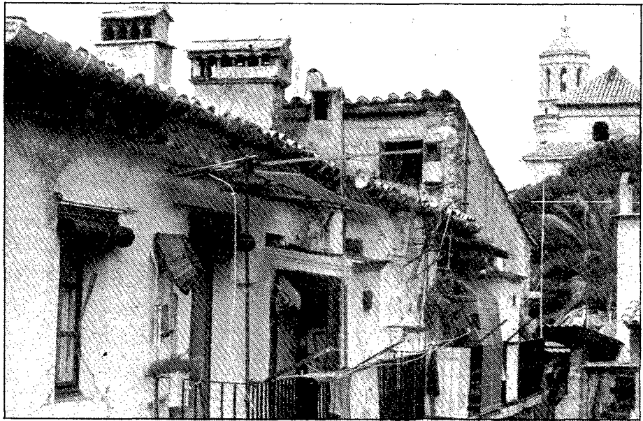
«Una casa al barri vell de Girona. No està enrunada però cau de vellúria i precarietat».
