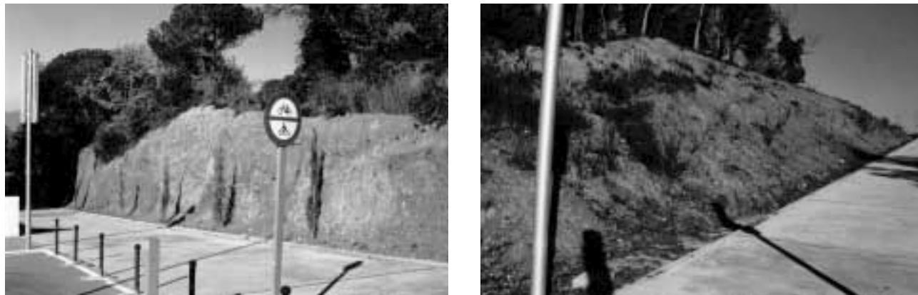
Imatge dels talussos amb problemes d'erosió a la façana nord de la Facultat de Ciències Econòmiques i Empresariales
