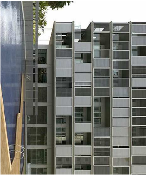
Edifici de vivendes a l'illa de la Llum Diagonal
