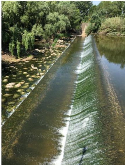
Riu Llobregat – Assut Captació ETAP – Cabal mínim
