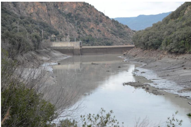
Estat del buidat de l'embassament del Pasteral (FEB20)
