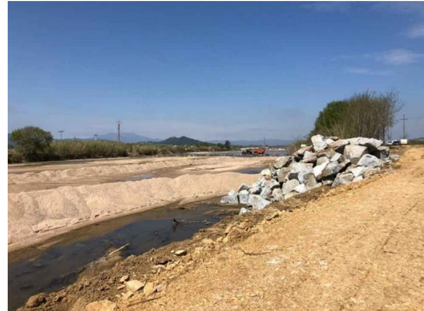
ITAM Tordera – Obres canonada captació
