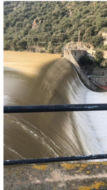
ETAP Ter – Presa del Pasteral
