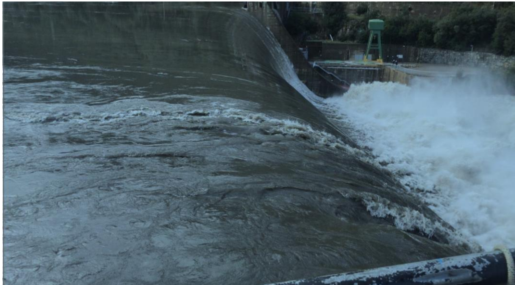
ETAP Ter – Presa del Pasteral
