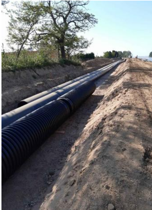
ITAM Tordera – Obres canonada captació
