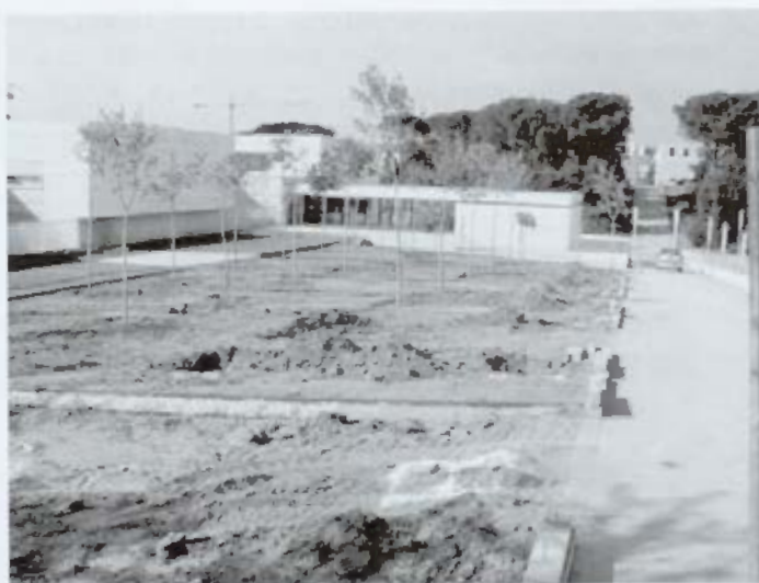
Obres que s'estan duent a terme per condicionar el jardí exterior de la Facultat de Dret
