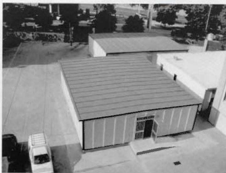
Vista dels mòduls prefabricats instal·lats a l'aparcament d'Emili Grahit
