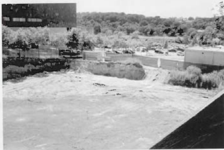
Moviment de terres al solar on s'amplia la biblioteca de montilivi
