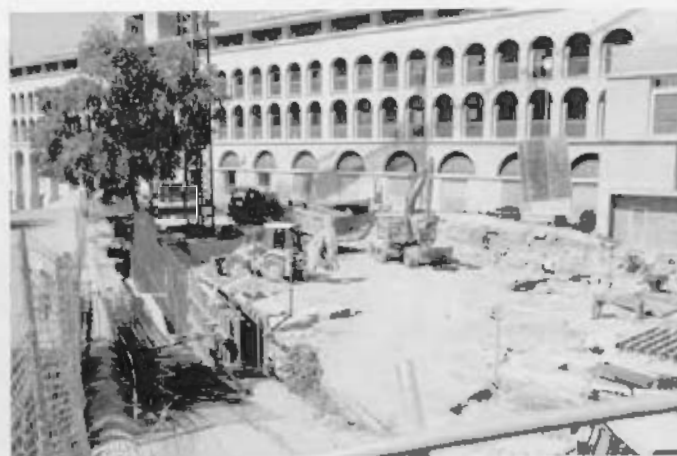
Obres a la Biblioteca al Campus del Barri Vell (cos E)
