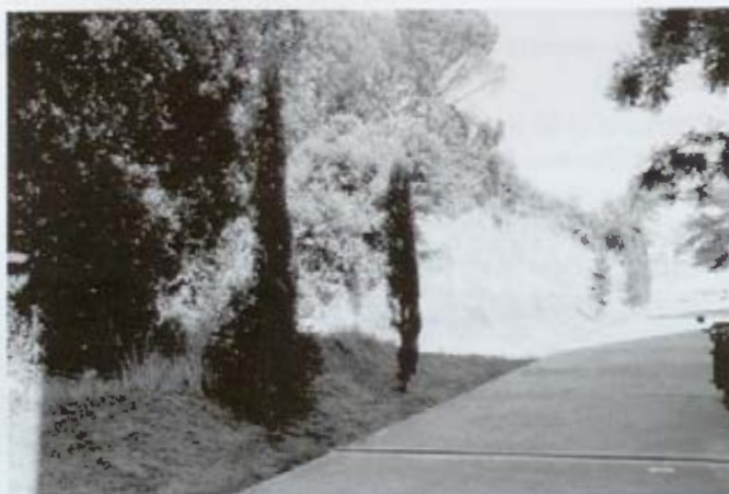
Vista parcial d'un dels marges consolidat
