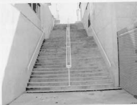
Baranes a l'escala entre l'edifici de tallers i PIV
