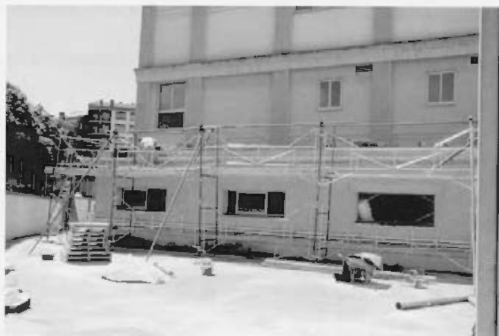
Reforma de l'aula 0
