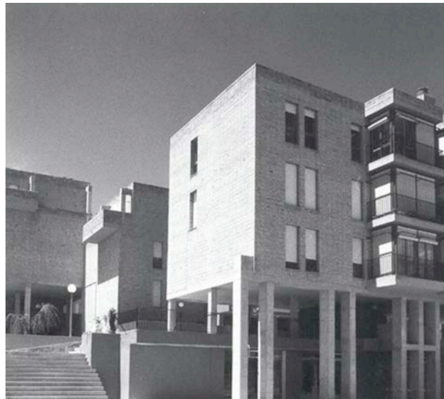
1973-76 Barri d'Habitatges Anca, Montblanc
