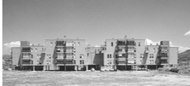
1973-76 Barri d'Habitatges Anca, Montblanc
